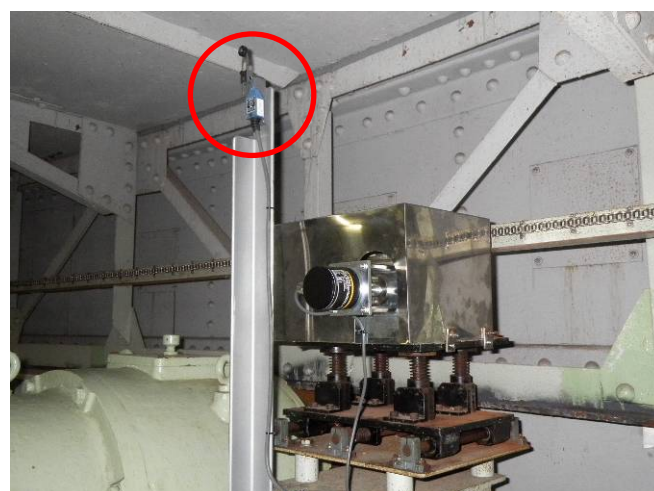
図5：ドーム旋回用のエンコーダと原点初期化スイッチ（赤円内）。制御室の屋上に取り付けられている。
