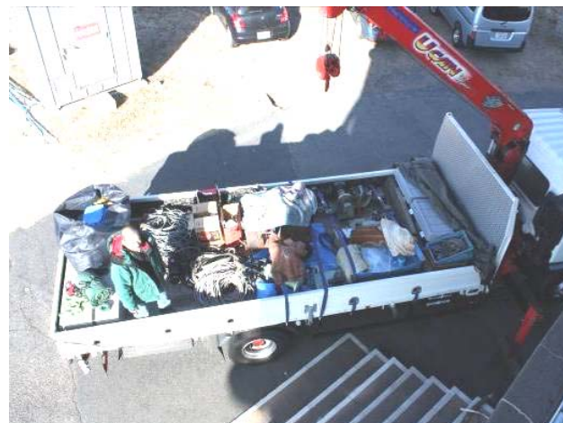
図 17. トラックに積まれた撤去物品。すべて廃棄でなく再利用する部品が多くあります
