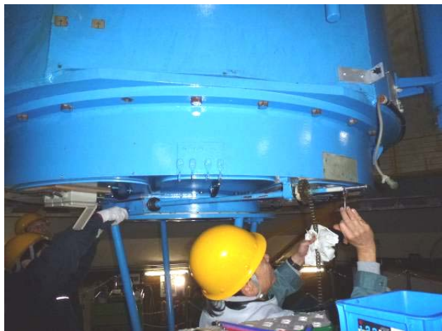
図2. 動力伝達パイプ、モーター、エンコーダを撤去
