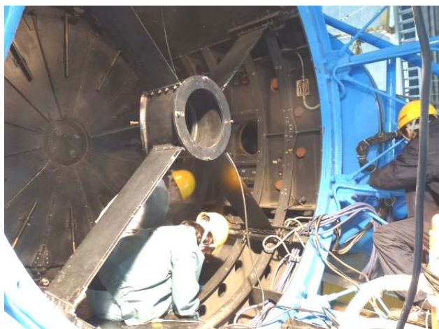
図12. 鏡筒センターピース内の配線撤去。中央はクーデ光路第三鏡支持スパイダー
