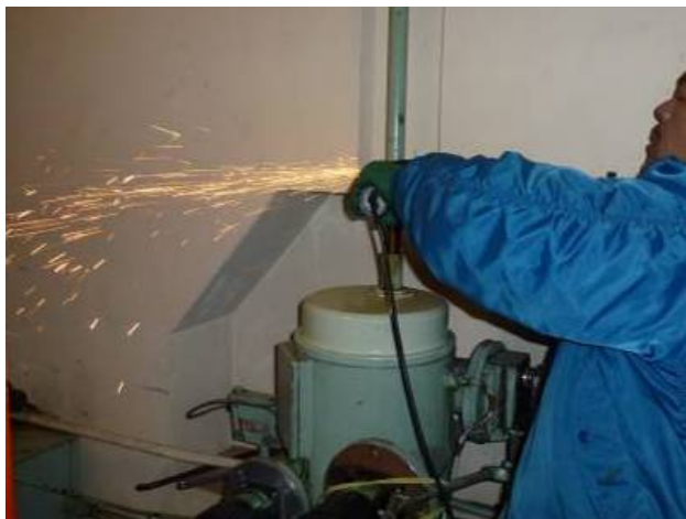
図 14. ドーム 1 階にある赤経軸の微動駆動系の動力伝達パイプ切断
