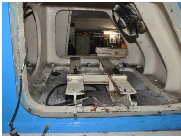
図11. 赤経軸粗動系が取り除かれた極軸南側軸受台の内部
