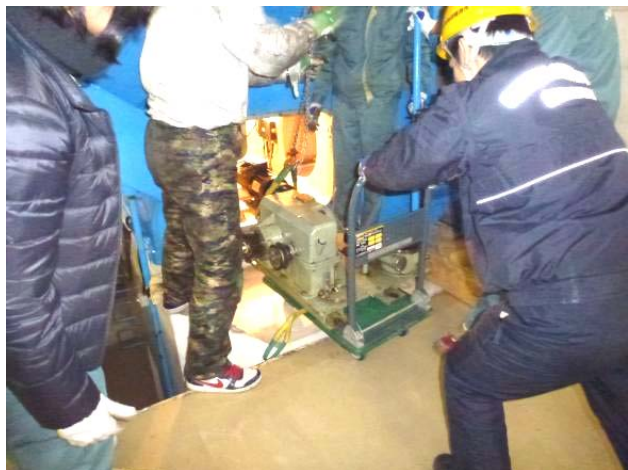
図10. 赤経軸粗動系モーター・ギアボックス等の取り出し
