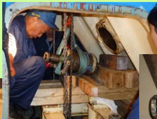
軸受部を取り外す
